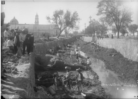
Río San Juan de Dios con muros de contención (nipnoticias.blogspot.com)
